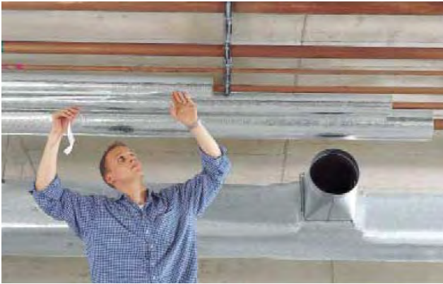
Montage der Dämmschale RS 800 an Heizungs- und Trinkwasserleitungen
