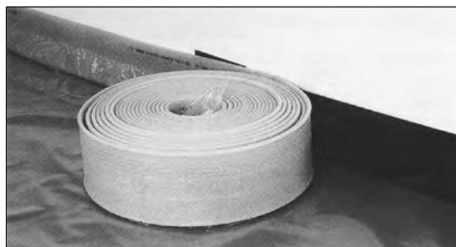
2. PE-Randdämmstreifen TF mit Folienflansch abwickeln und entlang der Wände auf der besenreinen Rohdecke aufstellen. Bei Fliesenestrich ist der **emcal** Randdämmstreifen Typ TF-2K mit 2 Klebestreifen einzubauen. Der Folienflansch zeigt zum Raum hin.
