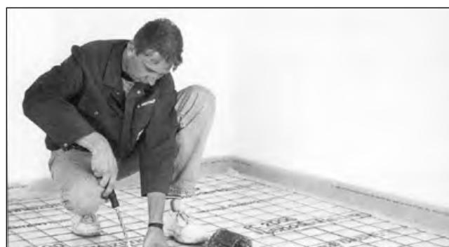
5. Trägermatten mit den Mattenbindern und dem Drillgerät zu einer Einheit verbinden.
