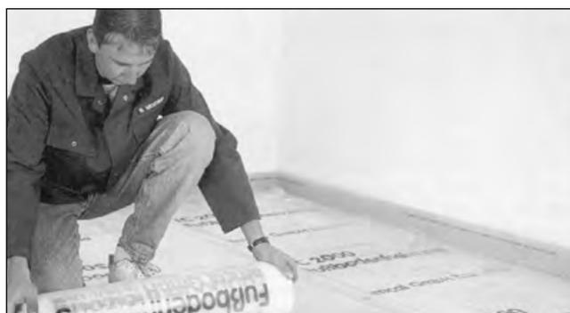
3. Schutzfolie ausrollen, aufklappen und mit 10 cm Überlappung bis zum Randdämmstreifen auslegen.
