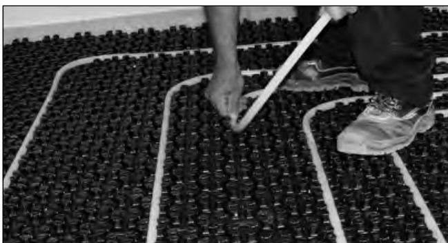
7. Danach erfolgt die Rohrverlegung von der zentralen Verteilerstelle aus zu jedem Raum, der für die Fußbodenheizung vorgesehen ist. Es sind die Verlegeabstände gemäß den emcal Montageplänen zu beachten.
