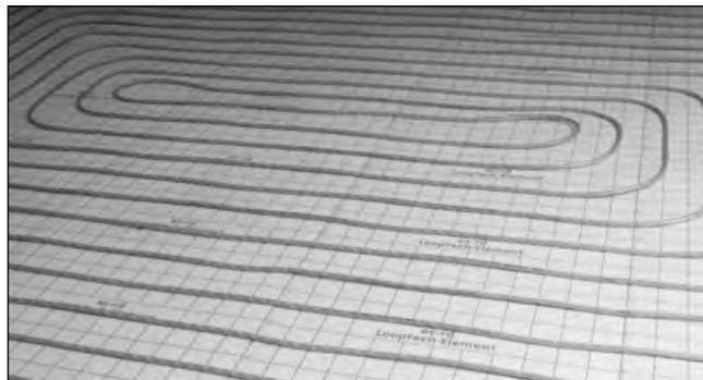
7. Nach dem Verlegen der Rohre entsteht eine ebene Verlegefläche mit exakten Rohrabständen für die Aufnahme von Estrichen. Zusätzliche Befestigungshaken werden nicht benötigt.
