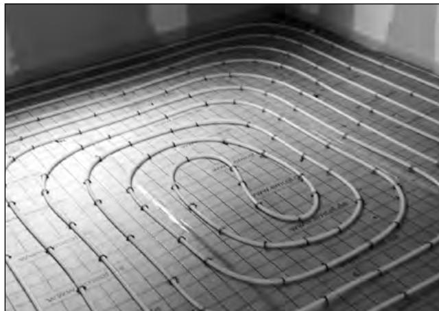
7. Nach dem Verlegen der Rohre entsteht eine Verlegefläche mit exakten Rohrabständen.
