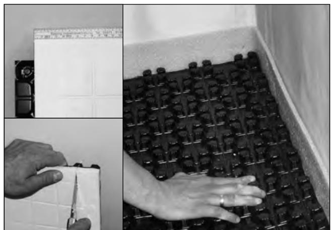
4. Am Raumende ist das Element passend zu kürzen und im Eckenbereich anzupassen. Mit dem restlichen Plattenabschnitt wird im linken oberen Raumbereich wieder begonnen. Somit entsteht kaum Verschnitt beim Verlegen (siehe Verlegeschema Seite 5). Der Folienflansch des Randdämmstreifens ist in die erste Noppenreihe zu legen und entsprechend zu sichern (siehe auch Abb. 1).
