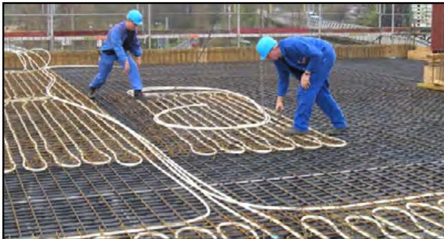
Bild 6: Verlegte **Thermoaktiven Decke**
