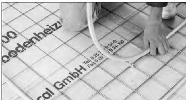
7. Rohrclips (je Meter ca. 3 Stück) auf den Mattenstegen aufclipsen und anschließend das **emcal** Sicherheitsrohr 17 mm nach Verlegeplan verlegen.
