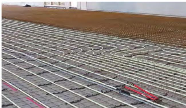
Darauf wurde dann die systementscheidende obere Bewehrungslage verlegt mit der die gewollt auftretenden Risse im CCF® System an der Oberseite überbrückt werden und sich an der Unterseite weiter öffnen.
