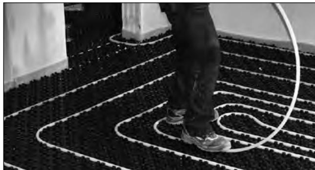
8. In Raummitte wird das Rohr mit einer Wendeschleife von 180° wieder zurück zum Verteiler im gleichen Verlegeabstand geführt. Der kleinste Biegeradius beim Folien-Noppenelement sind mind. 2 Noppenabstände, also 110 mm. Natürlich kann auch ein größerer Umlenkungsabstand gewählt werden (Empfehlung 220 mm).
