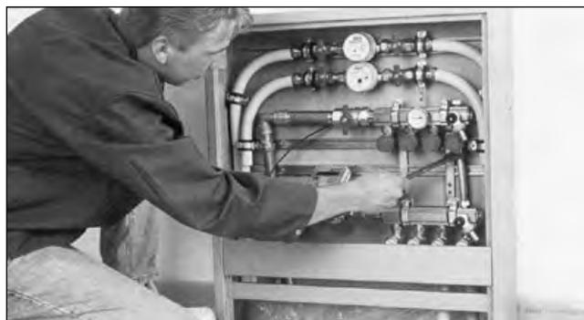
8. Ebenfalls einen Rohrführungsbogen überschieben, danach das **emcal** Rohr an den Rücklaufstamm anschließen.
