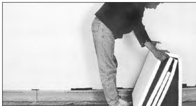
3. Rollisolierung auslegen. Bei zwei Lagen Dämmung fugenversetzt verlegen. Anschließend ist der Folienflansch des Randdämmstreifens über die Rollisolierung zu legen. Beim Typ TF-2K ist der Klebestreifen am Folienflansch abzuziehen und auf die Rasterfolie zu fixieren (Luftpolster darunter vermeiden).
