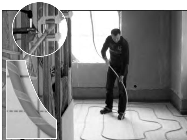
5. Nach dem Auslegen der Klettelemente wird das **emcal** Klett-Rohr verlegt. Zusätzliche Führungszwingen ermöglichen eine 1-Mann-Verlegung. Das Microklett-Haftband hält das Rohr perfekt am Element fest.
