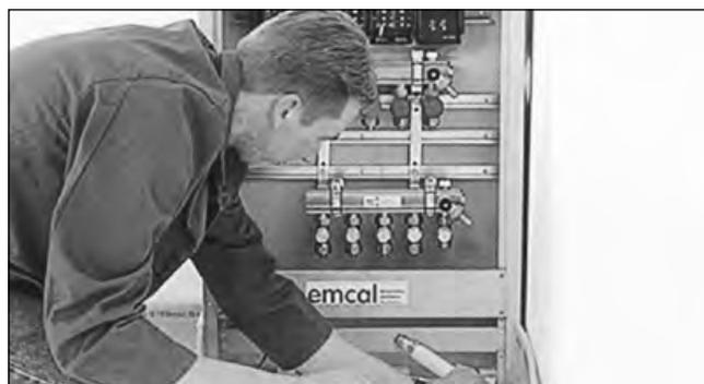
5. Rohrführungsbogen über das **emcal** Rohr schieben und am Verteiler anschließen.
