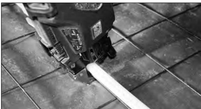
7a. Anstelle der Klipse kann das Rohr auch mit Bindendraht mit einer Kabelbindermaschine befestigt werden. Das **emcal** Aluflex-Rohr 16 mm wird generell mit Bindendraht befestigt.
