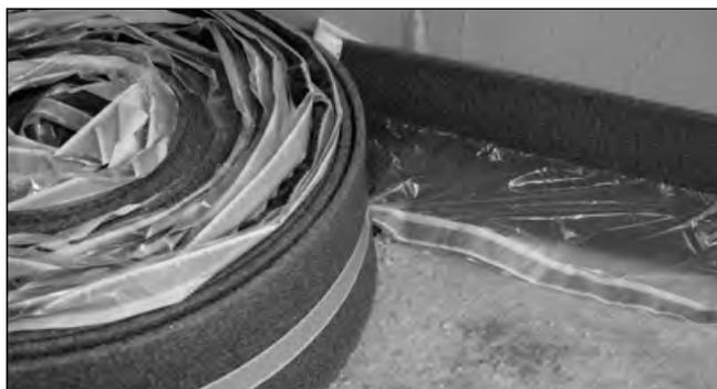
2. PE-Randdämmstreifen TF-2K mit Folienflansch und Klebestreifen abwickeln und entlang der Wände auf der besenreinen Rohdecke oder Unterdämmung aufstellen. Auch für Fließestriche geeignet. Der Folienflansch zeigt zum Raum hin.
