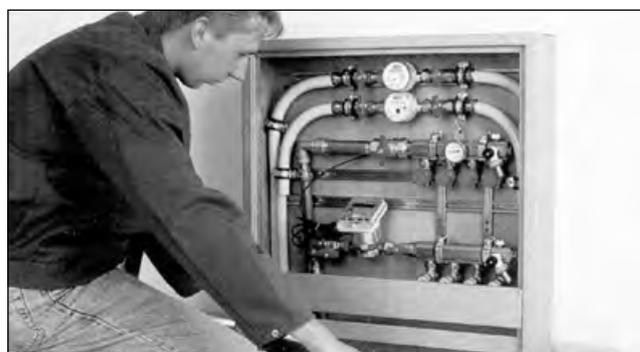
6. Einen Rohrführungsbogen über das emcal Rohr schieben, an den Vorlaufstamm des Verteilers anschließen und bei bifilarer Verlegung im doppelten Verlegeabstand bis zur Wendeschleife verlegen.
