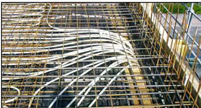
Bild 7: Anschluss der Rohre an den Verteiler
