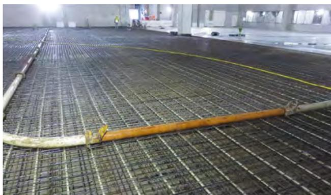
Danach konnte die Betonpumpe und die Betonfahrmaschine aufgestellt werden. Erst dann floss der NSB Nuttschichtbeton für die riesige fugenlose Fläche, den die Mitarbeiter der HIT GmbH in genau vorgeschriebenen Abschnitten verteilten. So entsteht eine bereits sehr plane Ebene. Nach einer Hydratationszeit von ca. 4 bis 8 Stunden wird auf den dann begehbaren NSB Nuttschichtbeton zusätzlich die HNS Hartkornnuttschicht frisch in frisch monolithisch aufgetra-
