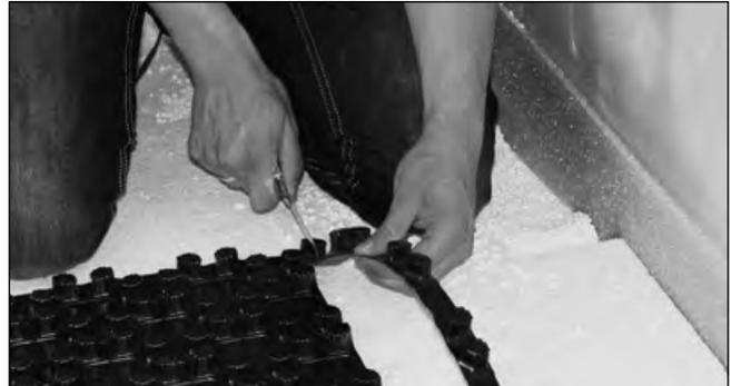
2. Das Folien-Noppenelement wird jeweils von links nach rechts auf sauberem Untergrund oder auf eine Zusatzdämmung verlegt. Bei jeder ersten Platte, beginnend links oben im Raum, wird zuerst der Folienüberstand abgeschnitten. Ebenso bei den Platten der ersten Wandreihe (siehe auch Verlegeschema Seite 5).
