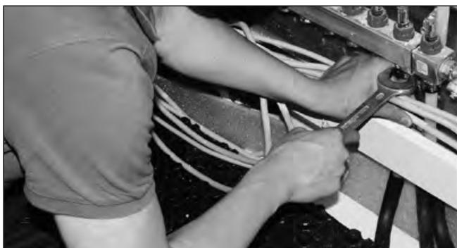
6. Danach wird das **emcal** Rohr 14-16 mm (Kreis für Kreis) an die Vor- und Rücklaufstämme der Edelstahl- bzw. Messing-Verteilerstämme angeschlossen. Der Anschluss der Rohre erfolgt über Quetsch-Adapter in entsprechender Rohrdimension. Die **emcal** Verteiler werden vormontiert auf Halterungen geliefert. Der Vorlaufstamm ist unten angebracht. Der Rücklauf oben. Ebenfalls im Verteilerbereich Rohrführungsbögen 90° über das emcal Sicherheitsrohr schieben und ausrichten.
