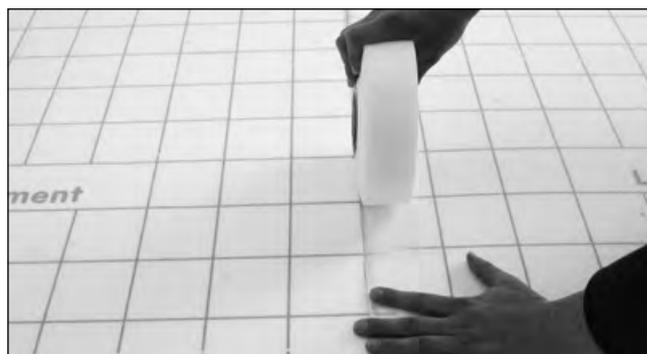
4. Der Überlappungsbereich der Klettelemente wird mit Klebeband dicht verschlossen.
