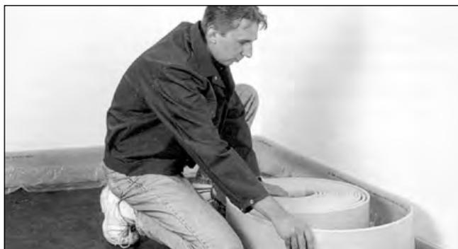
1. PE-Randdämmstreifen TF abwickeln und entlang der Wände auf der besenreinen Rohdecke aufstellen. Der Folienflansch zeigt zum Raum hin. Bei Fließestrich ist der Randdämmstreifen TF-2K mit 2 Klebestreifen einzubauen.
