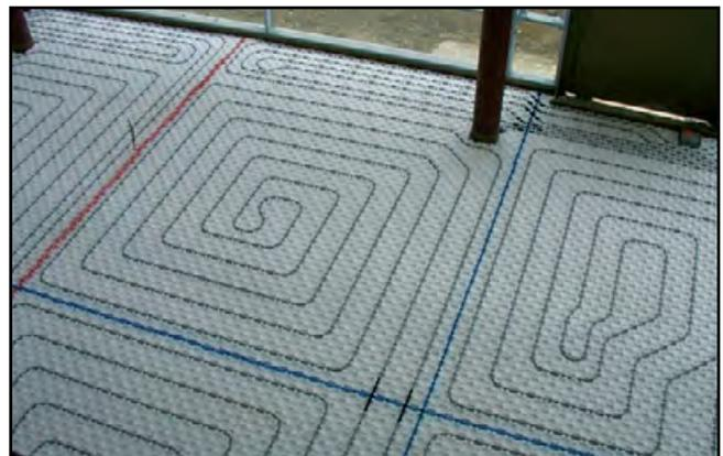
Bild 10: **emcal** Fußbodenheizung als Zusatzheizung
