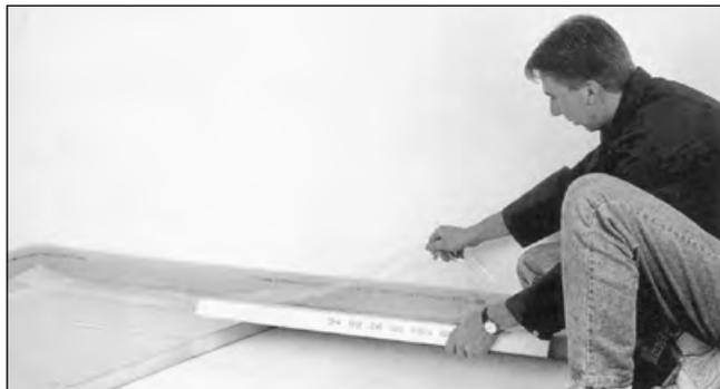
2. Wärme- und Trittschalldämmplatte auslegen. Bei zwei Lagen, z.B. gegen Erdreich, fugenversetzt verlegen. Anschließend ist der Folienflansch des Randdämmstreifens über Dämmung zu legen. Bei Fließestrich wird der Klebestreifen des Folienflansches (Randstreifen Typ TF-2K) auf die darunter verlegte Schutzfolie (Bild 3) aufgeklebt. Luftschlüsse sind zu vermeiden.
