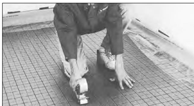
4. Der Überlappungsbereich wird mit Klebeband dicht verschlossen.
